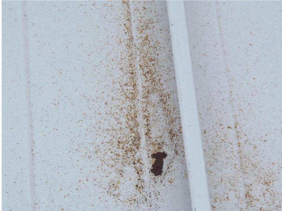
La posible causa de este deterioro se debe a que se careció de una adecuada limpieza a la hora de entregar la cubierta. Este descuido origina que la cubierta reduzca su vida útil y por ende la asignación de recursos para solucionar el problema.
