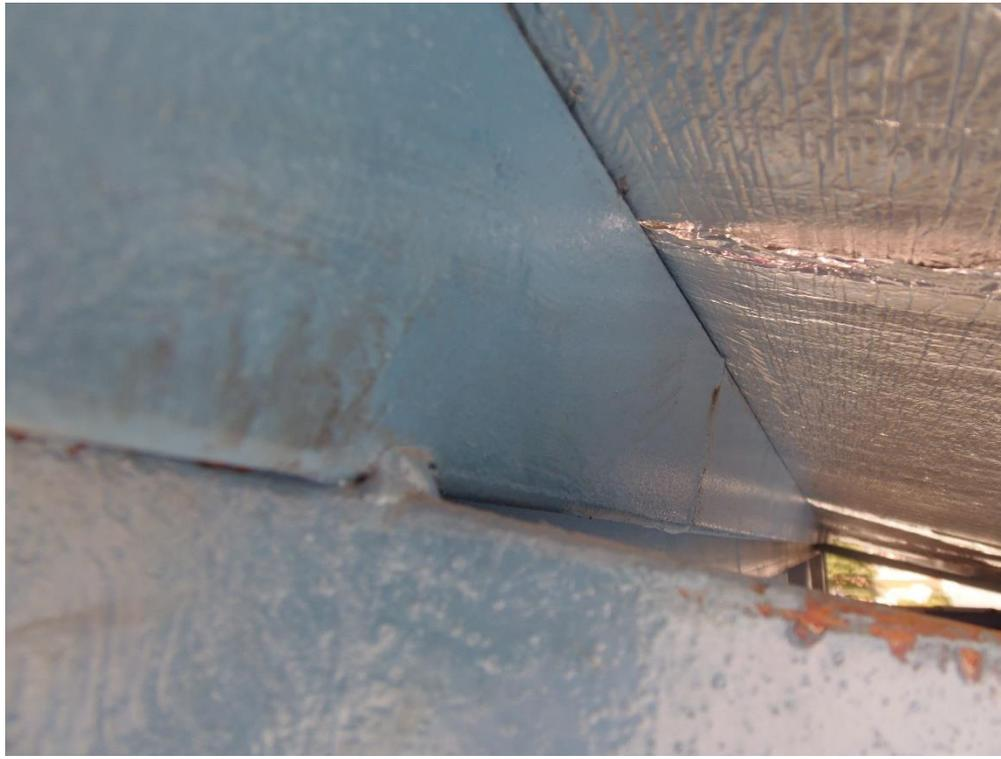
La posible causa de esta omisión se debe a la falta de inspección por parte del supervisor del proyecto. Esta falta origina una inadecuada sujeción del elemento y una menor rigidez.
