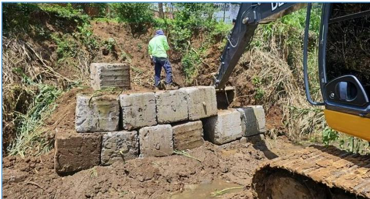
Se realizó la colocación de 30 cubos de concreto en forma de espigón, en la margen izquierda de la quebrada Chilamate para poder solucionar el tema de socavación y erosión que se presentaba en la Urbanización Marianela en el Porvenir.
