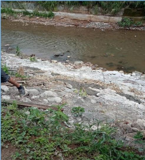
Colocación de 25 cubos de concreto en forma de espigón en Calle Benavides, Caso Patricia Durán y sobrina, adicionalmente se hizo un refuerzo con concreto y malla electro soldada, para mejorar el talud creado con la excavadora y así evitar una erosión del terreno colindante al río Cañas.
