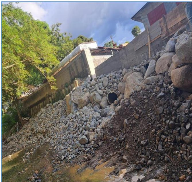
Construcción de muro de concreto ciclópeo en calle Antigua en San Juan de Dios, con una altura de 1.50m y un ancho de 50cm, con placa de cemento que viene a ayudar a la comunidad para evitar el ingreso del río durante una crecida.
