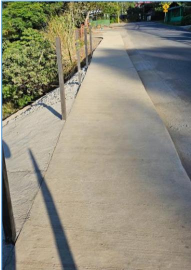
Construcción de protección fluvial en Higuíto, calle a Encinales. Se realizó un enrocado revestido con concreto, adicional se colocaron 50 cubos de concreto para poder rellenar el terreno perdido, adicionalmente se colocó una acera para que transiten las personas.
