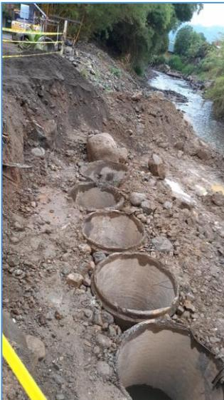
San Rafael Arriba, barrio La Granja a raíz de las inundaciones sufridas en el 2022, se da la necesidad de crear un muro de tuberías que consiste en colocar tubería rellena con estructura y concreto en forma de una pared con una longitud de 20m
