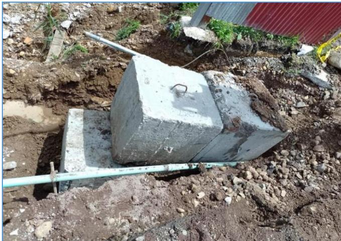
Colocación de 5 cubos para formar un pedestal y poder ubicar un puente metálico que funcione como paso peatonal, en el sector de barrio Cucubres por la caída del puente vehicular que comunicaba dicha comunidad.
