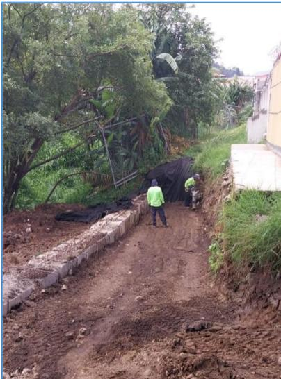
Se realizó la colocación de 50 cubos de concreto en forma de llave cortante en Urbanización Villas don Alfonso, esto se colocó en la base del deslizamiento presentado en el terreno, además de un relleno para con lastre mejorado para estabilizar, esto fue causado por aguas residuales de propiedades privadas mal encausadas, en Urbanización Villas don Alfonso.
