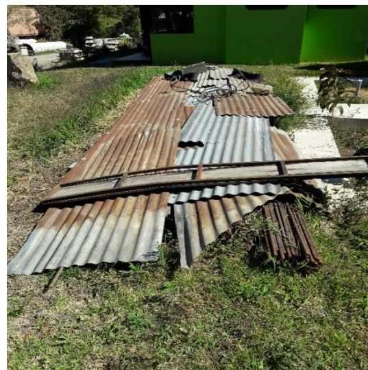
Foto 4: VARILLAS A LA INTEMPERIE
