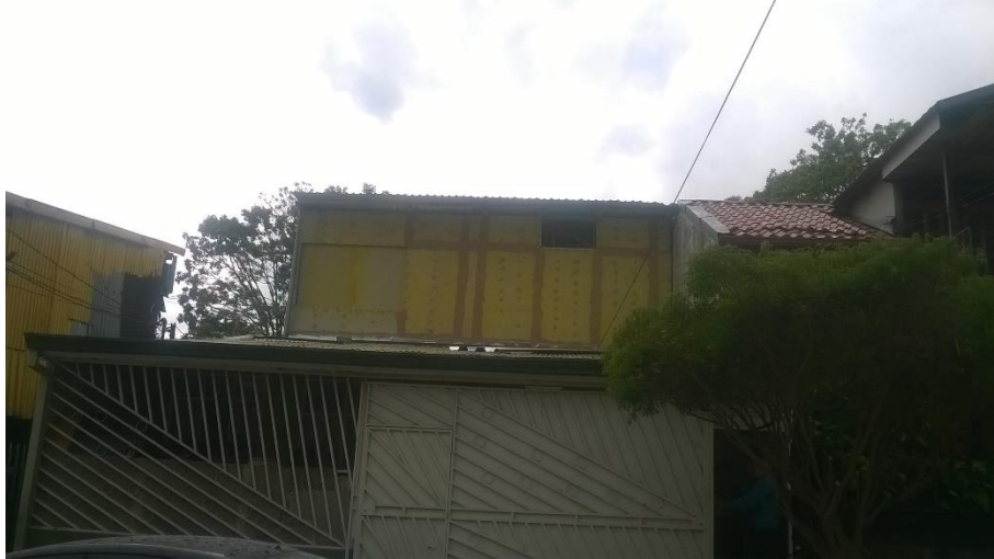
Foto N° 9: Construcción pequeña cerrada, sin ejecución de obra.
