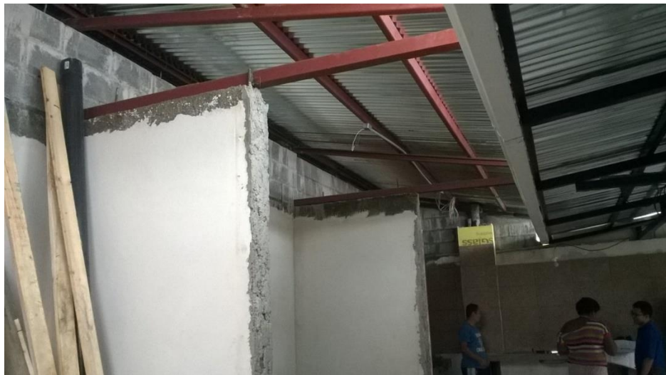
Foto N° 2: Construcción al 100% de la propiedad.
