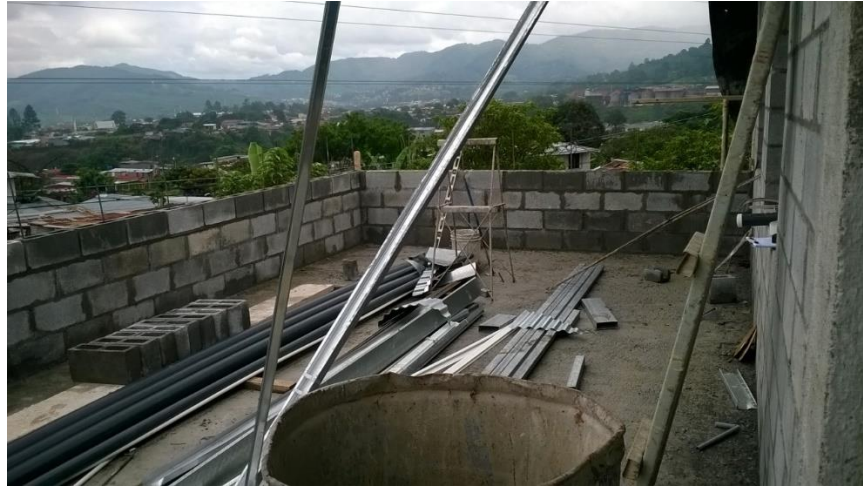
Foto N° 5: Construcción de techo por entrepiso.
