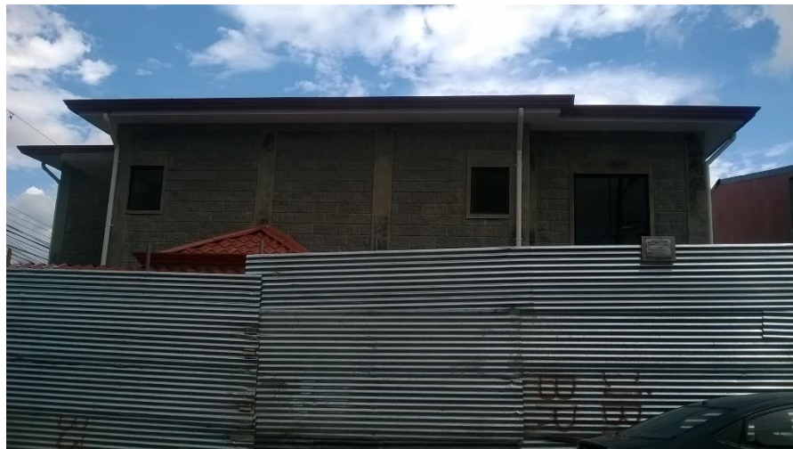
Foto N° 8: Construcción cerrada, sin ejecución de obra.
