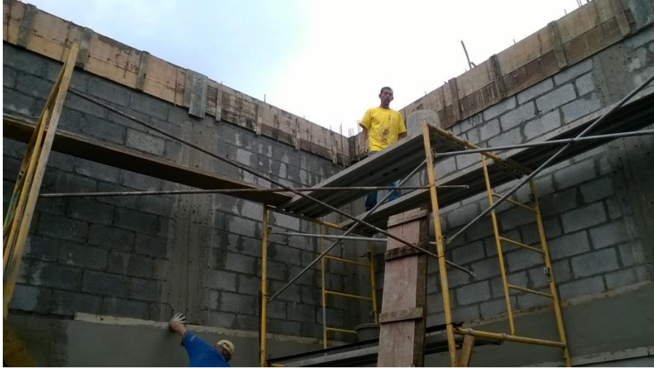
Foto N° 7: Construcción conforme a los permisos otorgados.
