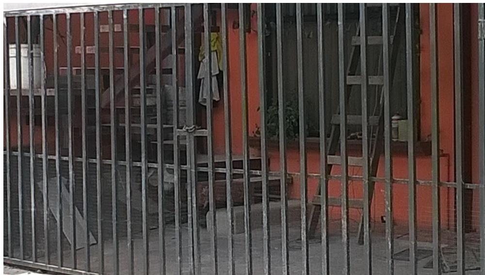
Foto N° 1. Construcción de escaleras en el retiro frontal
